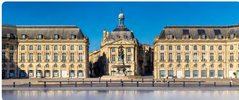
Place de la Bourse / Miroir d'Eau
